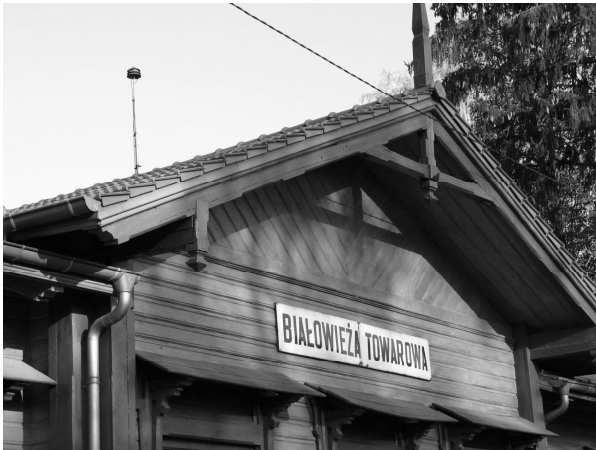
Fig. 4. ESE air terminal in Białowieża, Poland
